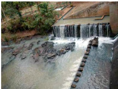
un'immagine dell'impianto di irrigazione
